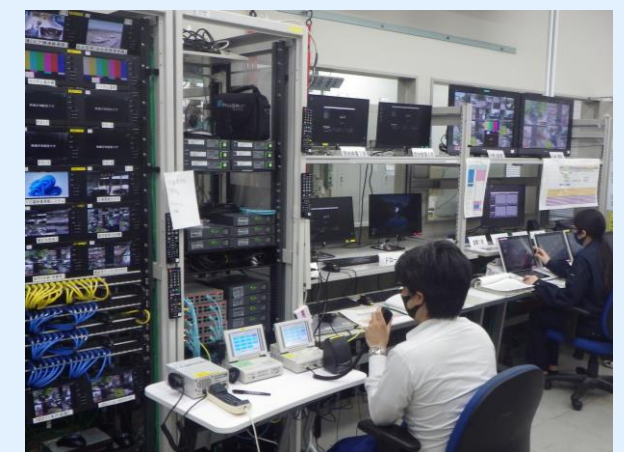
通信対策室の運用
