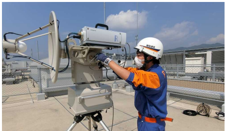
ヘリコプターテレビ用可搬自動追尾受信設備の立ち上げ訓練
