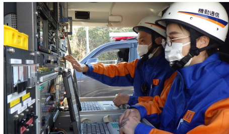
応急通信対策車の衛星設備での映像伝送訓練
